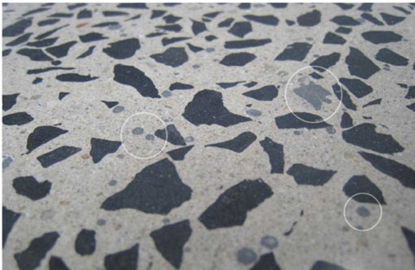
Los orificios se rellenan al amolar con diamantes con liga de metal de grano 120 y GM 3000™.
