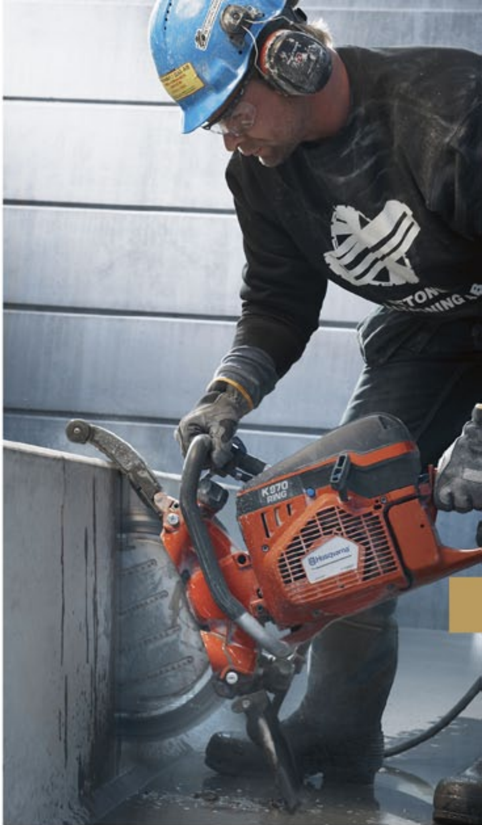
Profundidad de corte 270 mm, el doble de un disco tradicional.
